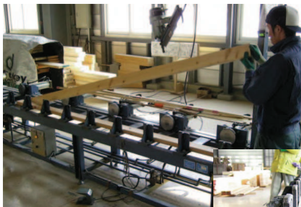
合わせ柱の組立
