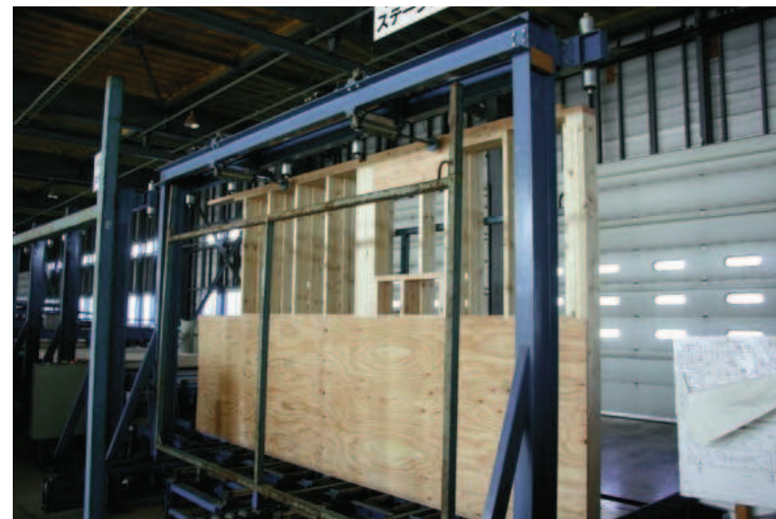
合板を張った壁フレーム
